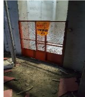
엘리베이터 안전난간대
