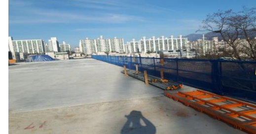
지하 주차장 단부난간대
