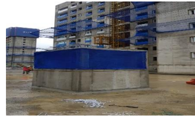
D/A 안전난간대 및 수직망
