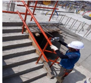
계단, 계단참안전난간대
