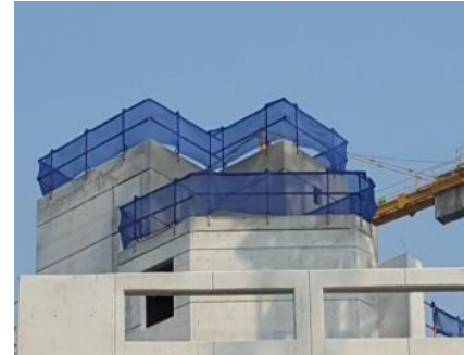
옥상 안전난간대
