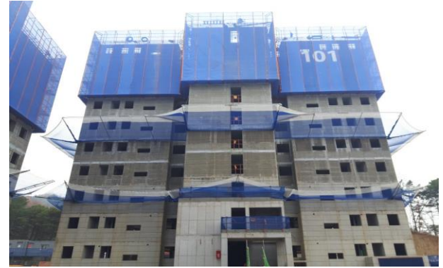
낙하물방지망 Fly-net 형 공사
