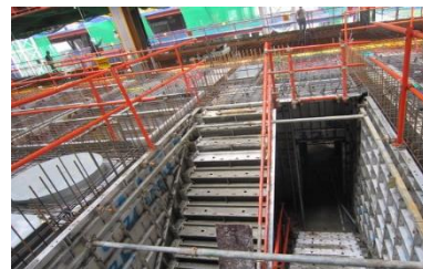
알폼 안전난간대
