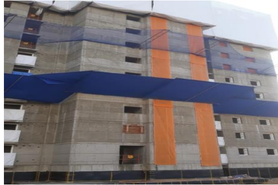
4*6 System 1단 낙하물방지망 공사
