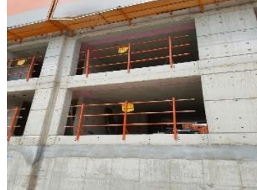
발코니 안전난간대
